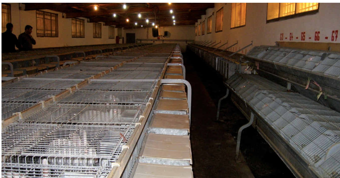
Bombillas fluorescentes en una nave de cría de conejos
