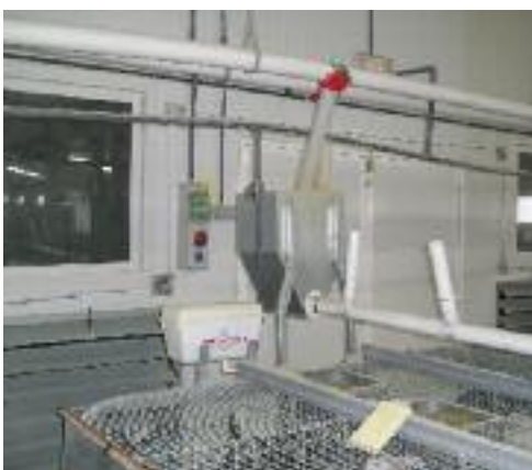
Detalle de la entrada de aire procedente del pasillo de acondicionamiento.
