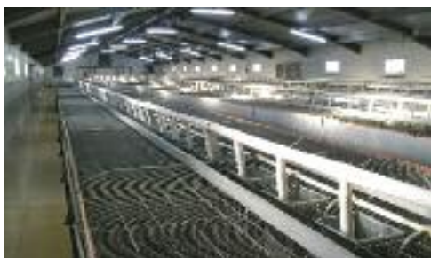
Interior de una de las naves después del vacío sanitario.
