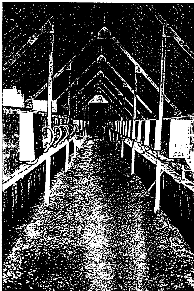
Otra nave, con un sistema de alojamiento parecido, en la que se puede apreciar como se ha cerrado el fondo y la altura interior de los muretes.
